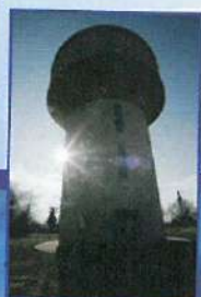
Réservoir sur tour «Le Plaix», Meaulne
