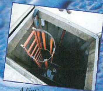
A l'intérieur du puits
