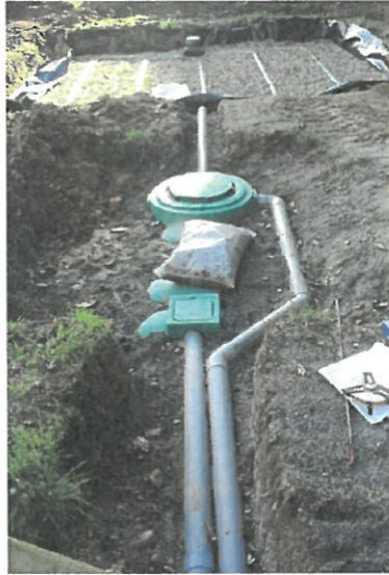
Filière d'ANC en cours de recouvrement (prétraitements et traitement visibles)
